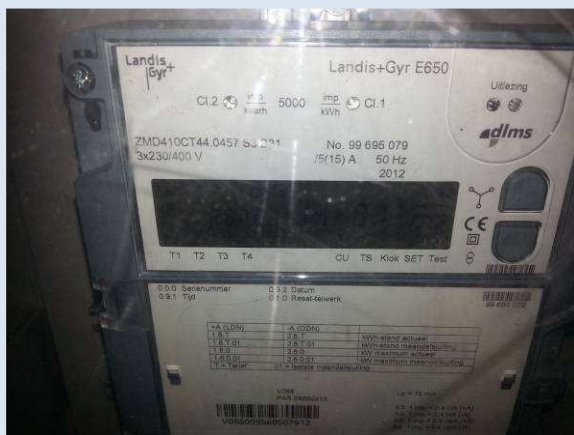
Elektra grootverbruikmeter
