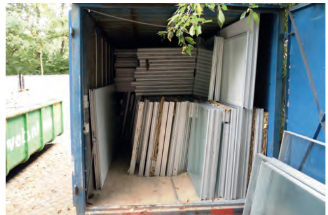
De systeemwanden zijn in een zeecontainer ingezameld en bij de sloper verder gedemonteerd.
