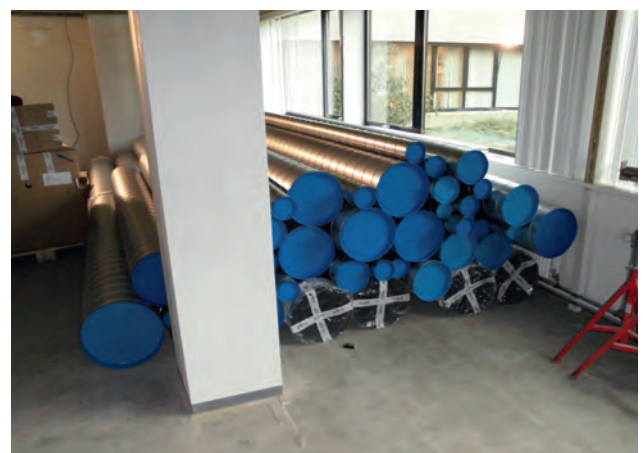
In het kader van het Indoor Quality Management Plan heeft de installateur alle kanalen afgedopt op de bouwplaats geleverd.
