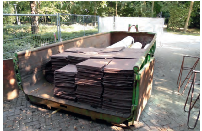
Vloerbedekking en tapijttegels zijn apart afgevoerd en worden hergebruikt in Polen.
