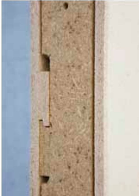
Vlasboard (detail opbouw systeemwand) MDF Eco (uit Ierland) viel buiten de toegestane maximale afstand. De oplossing werd gevonden in het oude Zeeuwse product vlasboard; Think global, act local!
